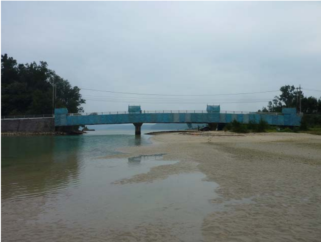
写真 1 : 測定対象となった沖縄県下の橋脚 1
