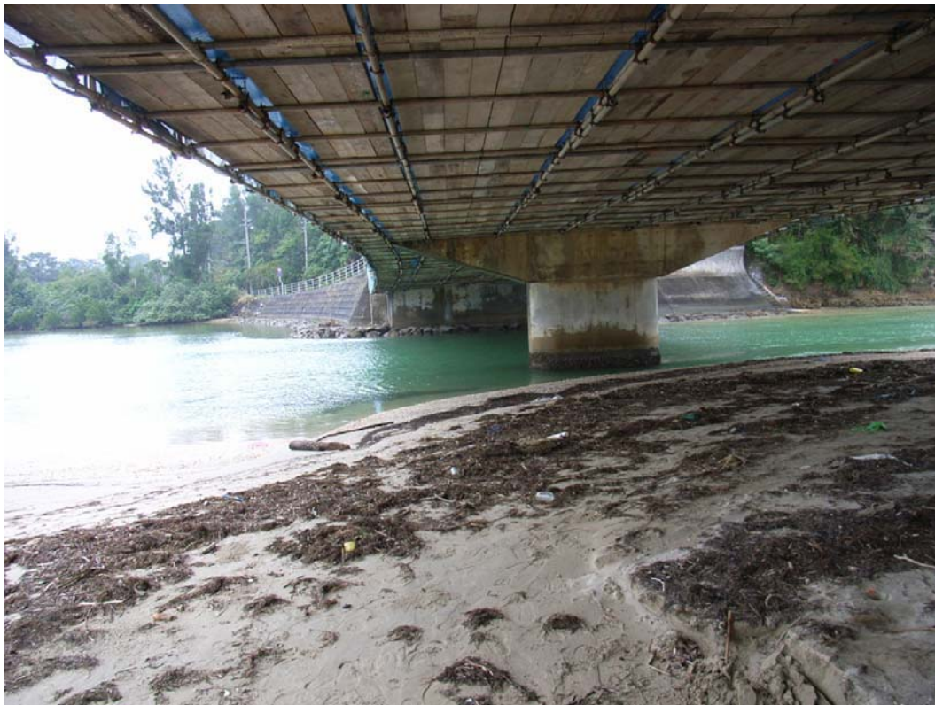
写真 2 : 測定対象となった沖縄県下の橋脚 2
